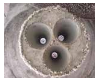
All'interno, l'unità è pulita e perfettamente funzionante.
